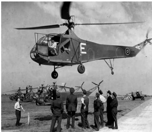
Der Sikorsky-R4, der ab 1940 als erster Hubschrauber in Serie produziert wurde - vor allem für die amerikanische Armee.
