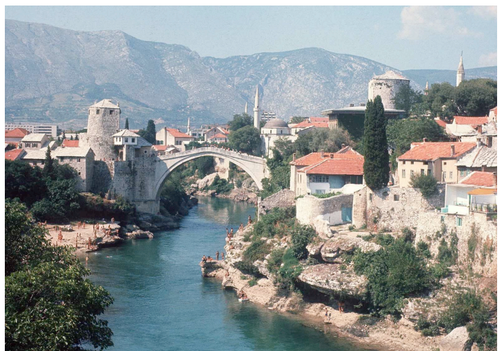
Die Bücke über die Neretwa in Mostar (Bosnien-Herzegowina). Sie verbindet den bosniakisch geprägten Ostteil mit dem kroatisch geprägten Westteil der Stadt. Sie war zur Zeit ihrer Erbauung im 16. Jahrhundert ein Meisterwerk der Ingenieurkunst. Die Brücke symbolisierte jahrhundertlang die Verbindung zwischen Ost und West, nicht nur zwischen der Welt des Christentums und der islamischen Welt, sondern auch zwischen den katholischen Kroaten und orthodoxen Serben. Die Brücke wurde im Bosnienkrieg zerstört. Später wurde sie wieder aufgebaut.
