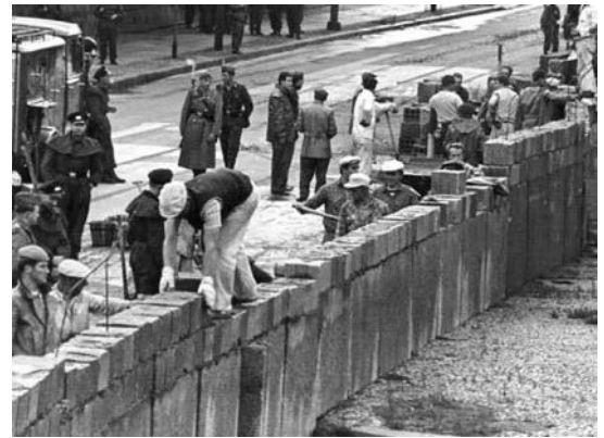
Bau der Berliner Mauer im August 1961
