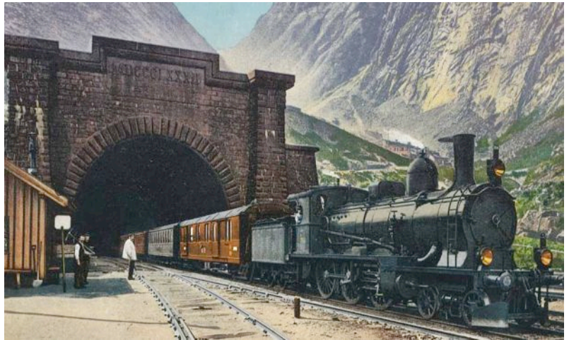
Nordportal des Gotthard-Scheiteltunnels bei Göschenen, Ende 19. Jh. Seit 1960 haben die beiden Spuren getrennte Eingänge, die sich nach 80 Meter mit der Hauptröhre vereinigen.
