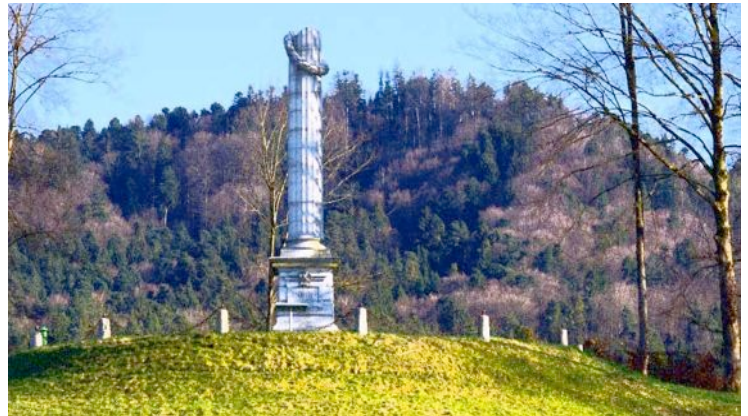
Denkmal am Grauholz bei Bern. Die weisse, abgebrochene Säule mit dem Kranz ist von der Autobahn aus gut sichtbar.
